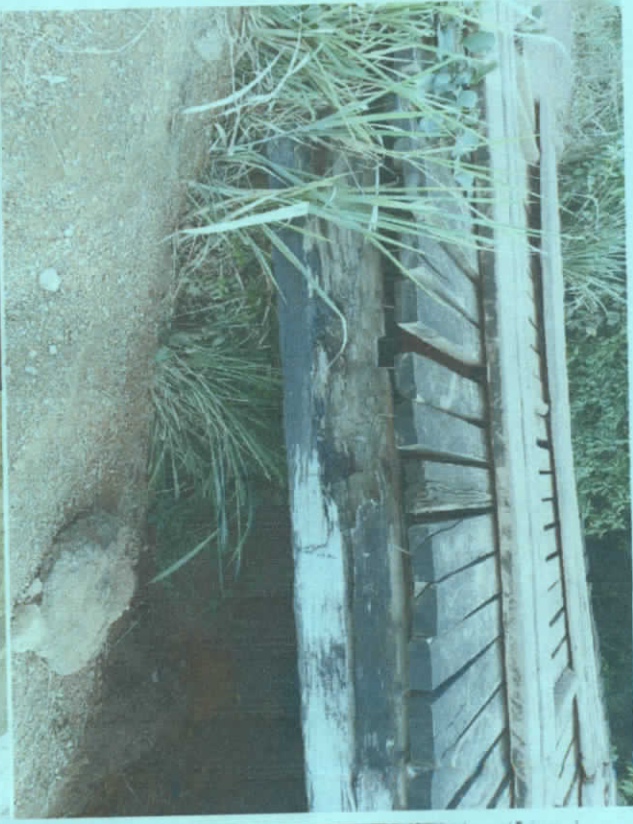
PONTE DO SETOR 7
