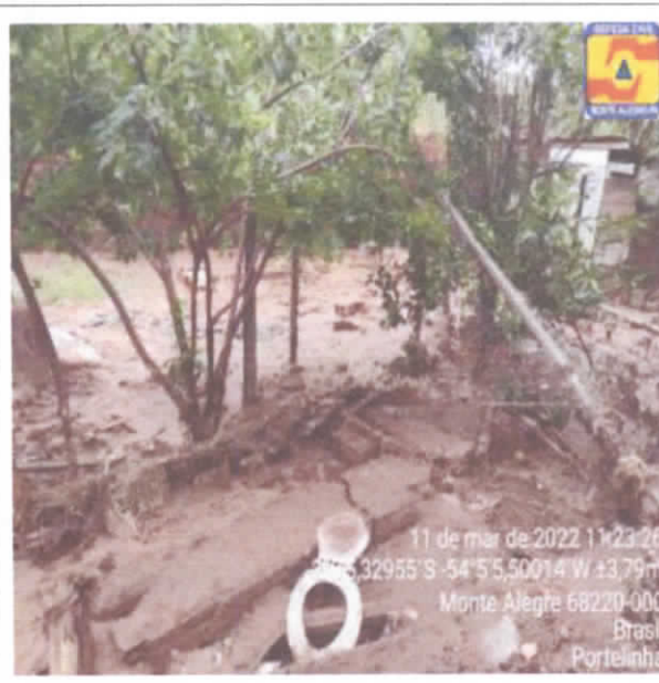
Travessa Laura Lins, o muro desabou pela força da enxurrada.
